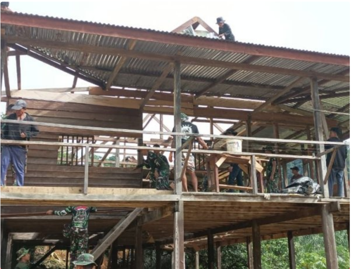
Foto Pembongkaran Rumah Warga
